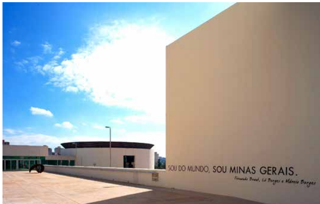
Ao fundo, o pavilhão que vai abrigar o Espaço Minas 360°
